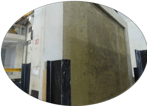
3) Duvar üzerine kaba sıva
